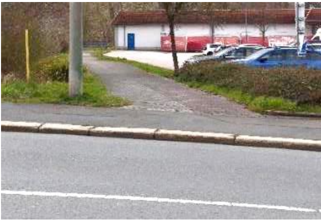
Begonnener Fuß- und Radweg Auestraße
