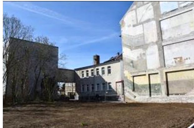
Baulücke Auestraße 11 u. 13
