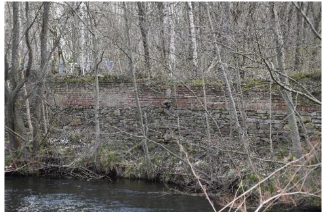
Stützmauer Uferbereich (Ufer Lindenstraße)
