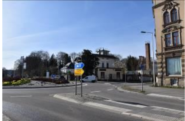
Neugestalteter Straßenbereich Meeraner Str.
