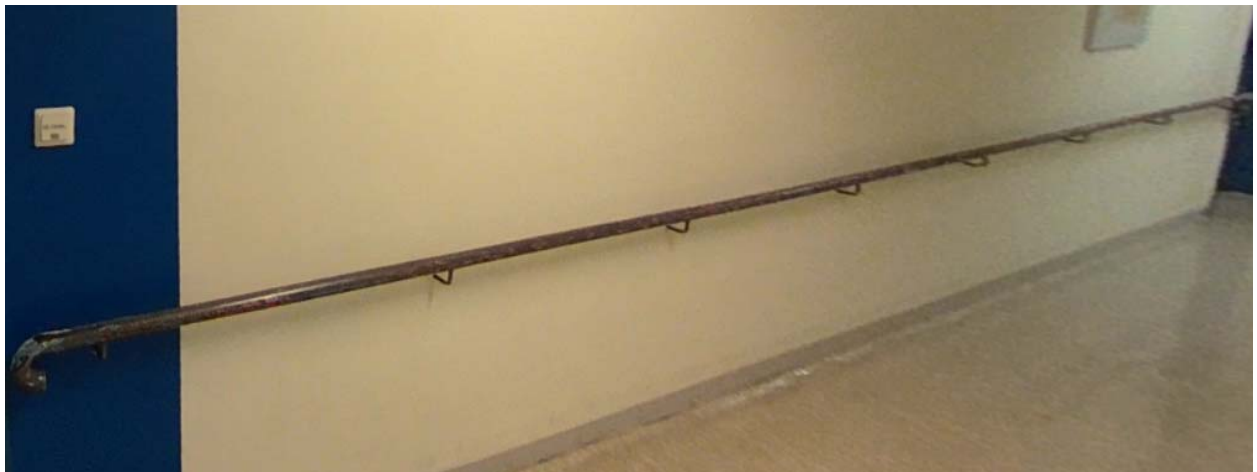
Bestandsfotos vorhandene Handläufe
