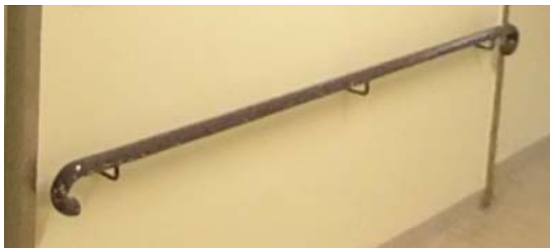
Bestandsfotos vorhandene Handläufe
