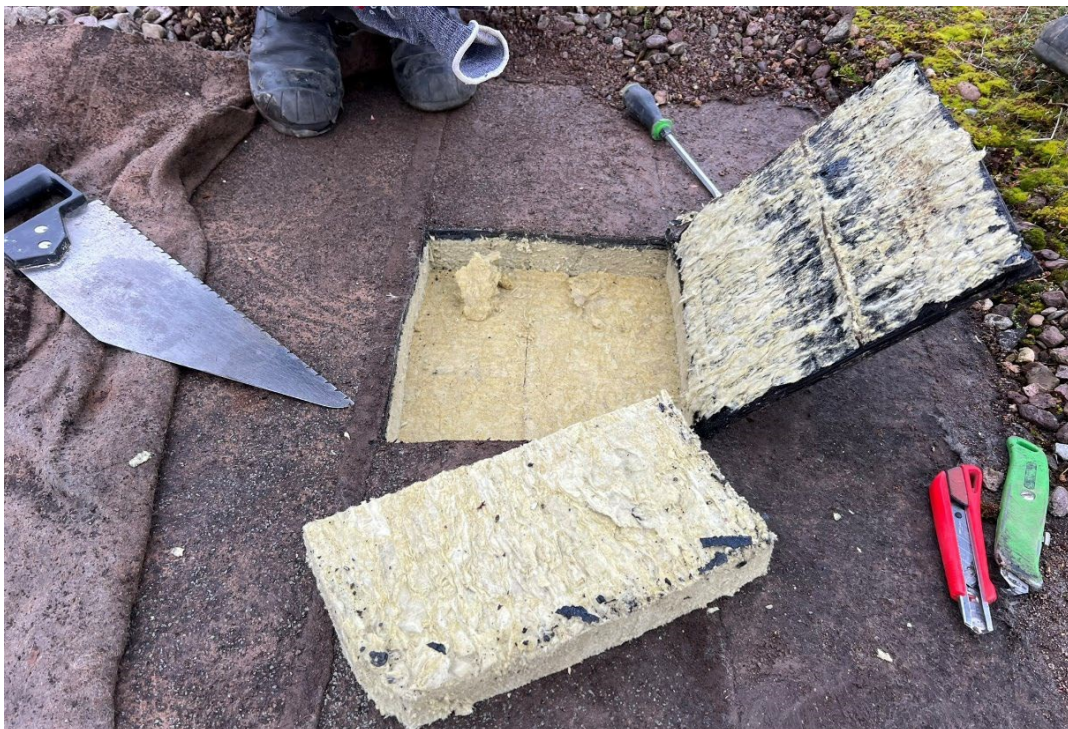
Abb. 17: Dachaufbau 4 – Öffnung Dämmschicht
