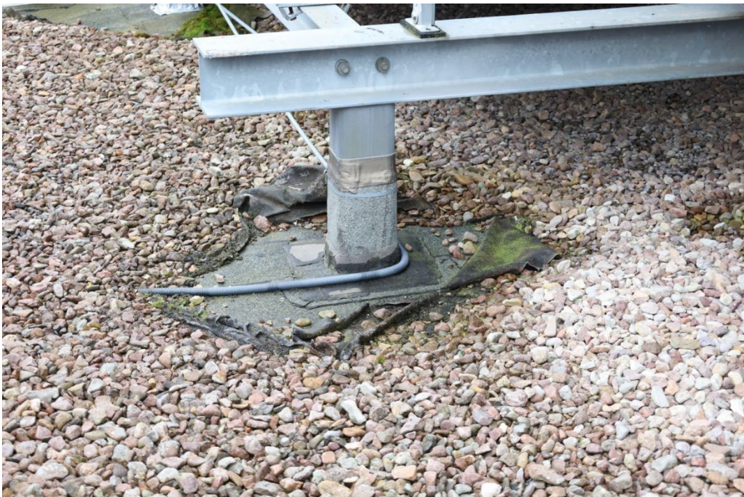
Abb. 29: Beispielhafte Abdichtungen von Dachdurchdringungen im Lagerbereich
