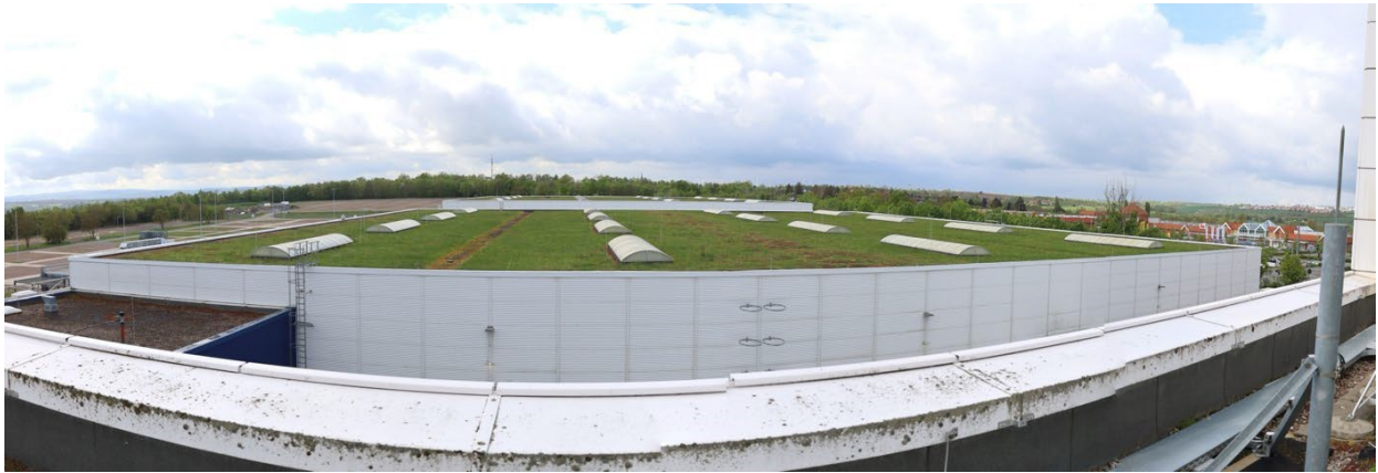
Abb. 2: Panorama Dachflächen Halle 2 und 3
