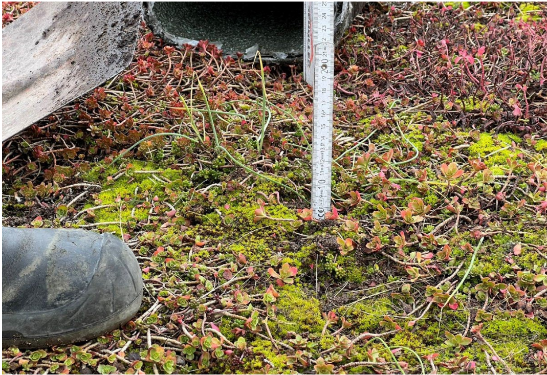
Abb. 14: Dachaufbau 1 – Höhe Grünbelag
