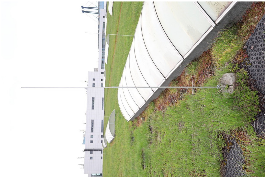
Abb. 21: Blitzschutz 2 - Fangstange
