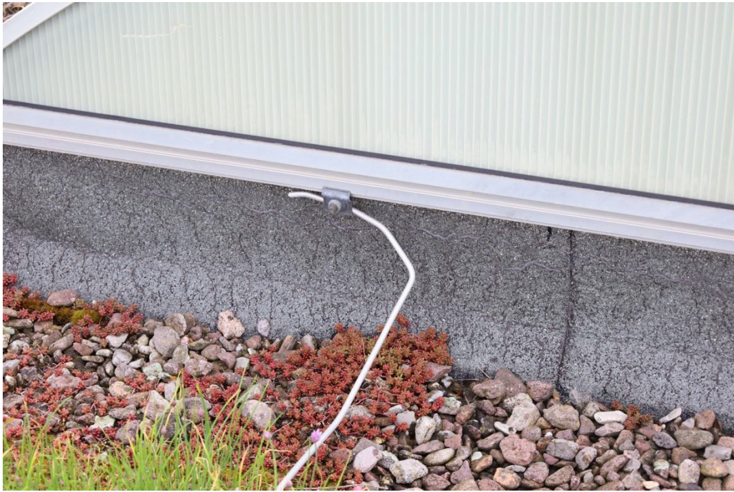
Abb. 22: Blitzschutz 3 - Anbindung Oberlichter
