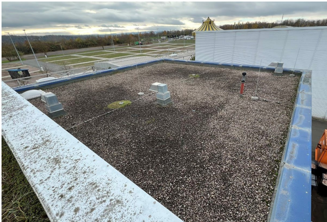
Abb. 23: Blick auf Technikgebäude 2
