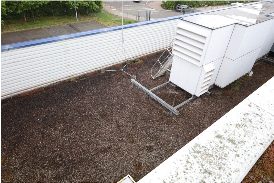
Abb. 24: Dachfläche Lagerbereich 1 - mit Blitzschutz und Lüftungsgeräten
