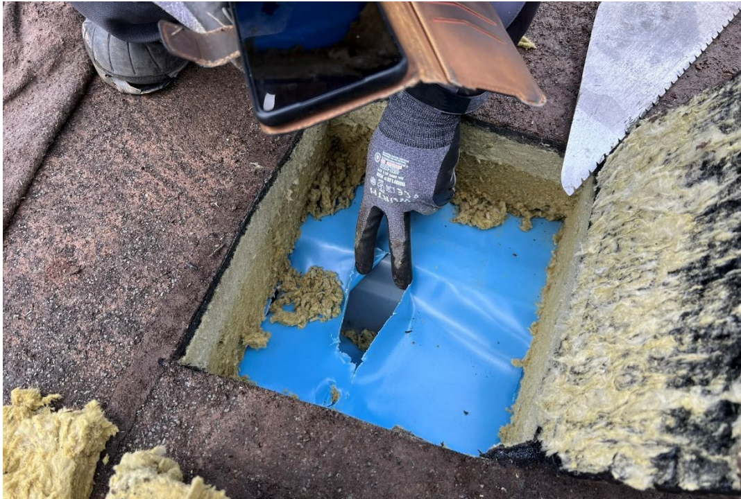
Abb. 18: Dachaufbau 5 – Öffnung Dampfsperre
