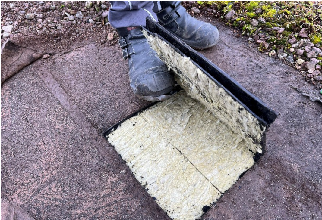
Abb. 16: Dachaufbau 3 – Öffnung Bitumenabdichtung
