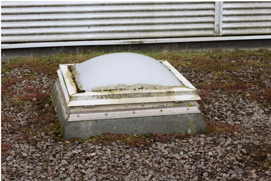
Abb. 27: Oberlicht Lagerbereich, teils mit RWA
