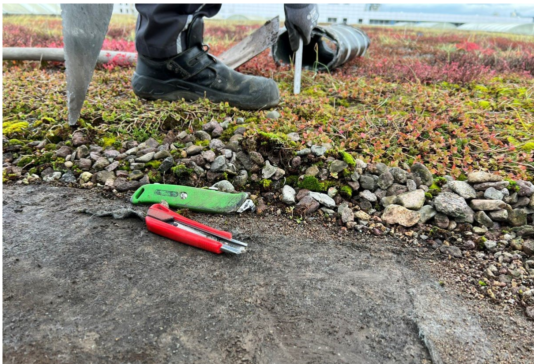
Abb. 15: Dachaufbau 2 – Höhe Querschnitt Grünbelag
