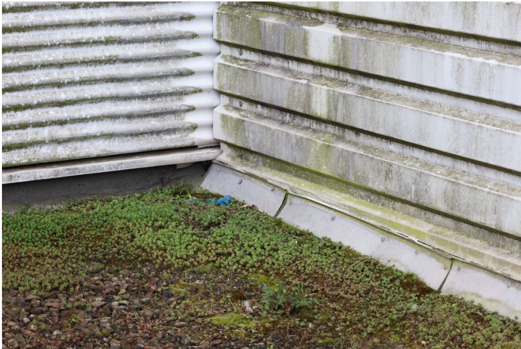
Abb. 28: Seitliche Anbindung der Abdichtung auf Lagerbereich
