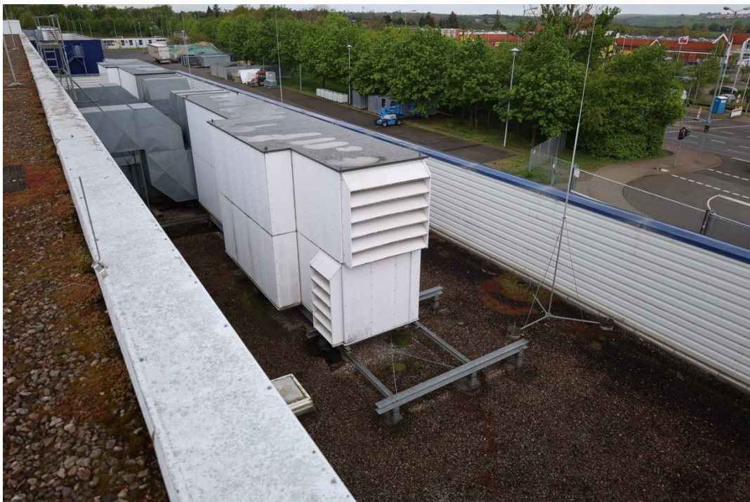
Abb. 25: Dachfläche Lagerbereich 2 - mit Blitzschutz und Lüftungsgeräten
