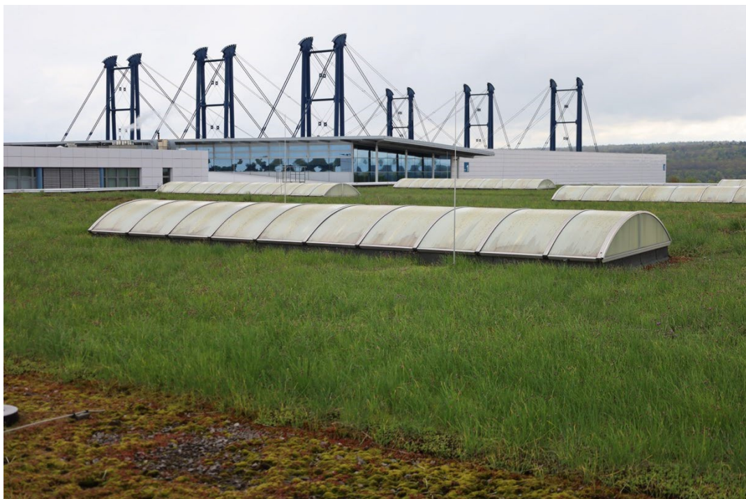
Abb. 3: Oberlichter mit Blitzschutz
