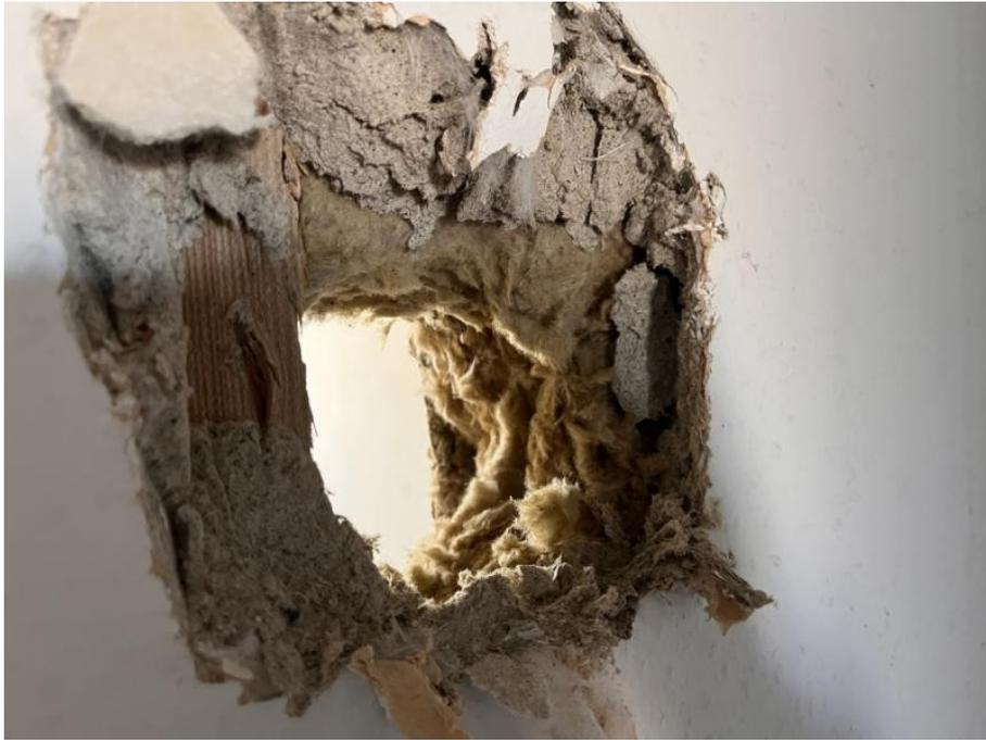
Aufbau Innenwände mit Faserplatte und Mineralwollgedämmung
