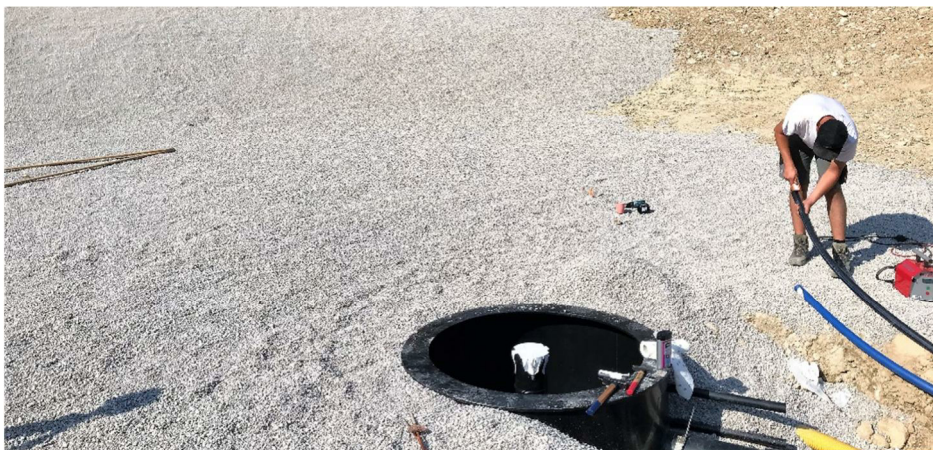
Beispiel Entnahmebauwerk in der Teichsohle vor der Verlegung der Wasserbaudichtungsfolie
