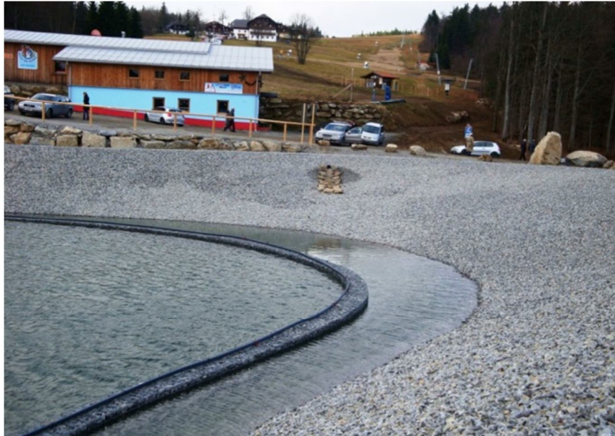
Schneiteich Wintersportzentrum Mitterfirmiansreut beim Befüllungsvorgang
