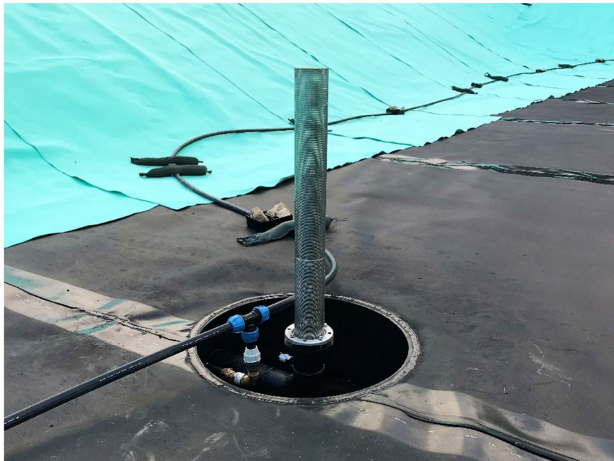
Beispiel Entnahmebauwerk in der Teichsohle nach der Verlegung der Wasserbaudichtungsfolie
