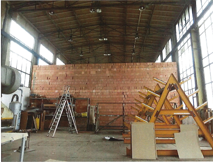
Bild 3: Gebäude 11 – bestandswand zu Haus 8
