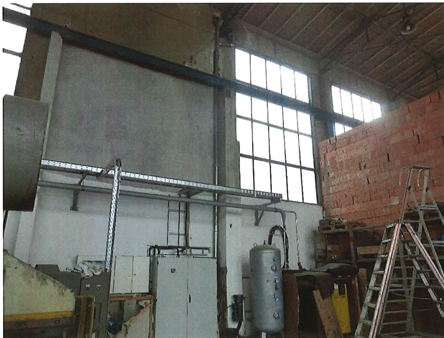
Bild 4: Gebäude 11 – Wand straßenseitig mit aussteifender Wand
