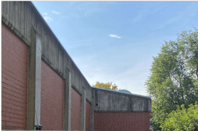
Ansicht von Norden: Bereich der geplanten Aufstockung
