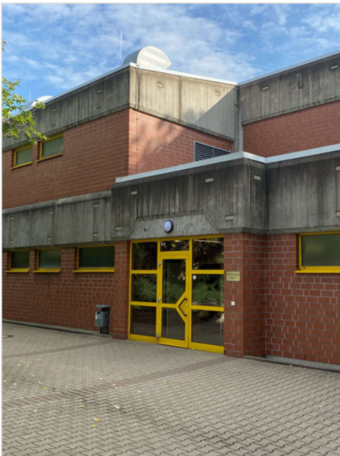
Ansicht von Westen: Bereich der geplanten Aufstockung
