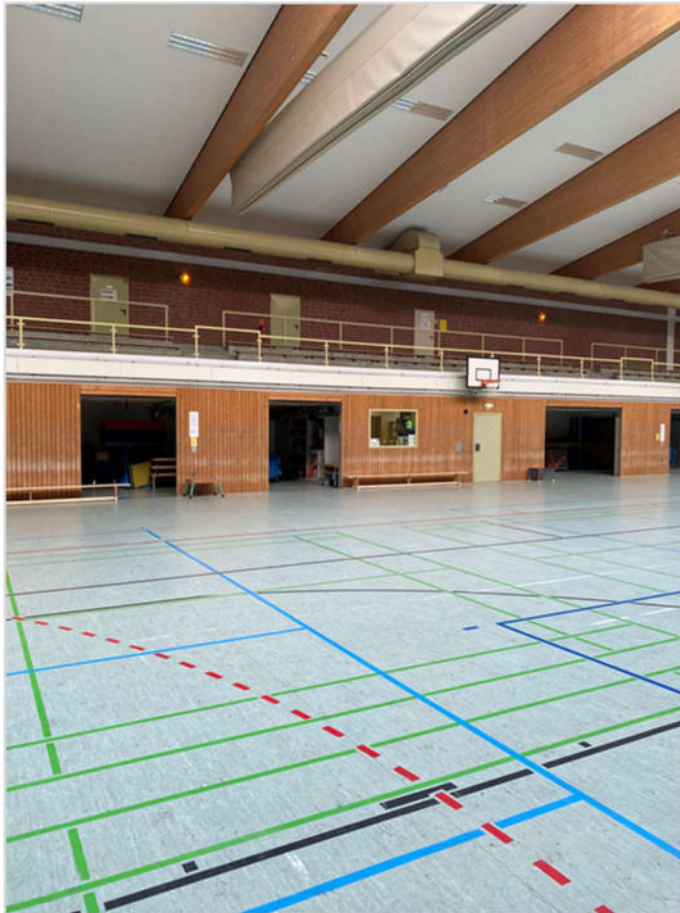
Sporthalle mit Prallwand aus Holz (Abweichung!) darüber Tribüne und Tribünengang
