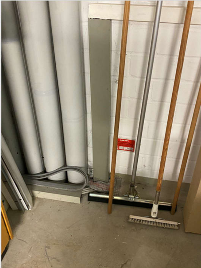
geschotteter Deckendurchgang der Elektroleitungen im Raum R 2.04
