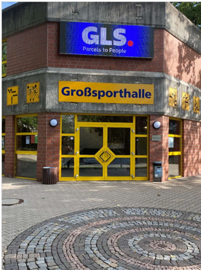
Haupteingang der Großsporthalle für Besucher
