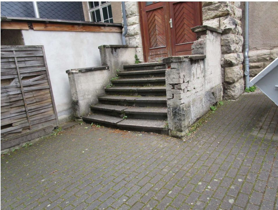
Anbau vorhandene Aussentreppe
