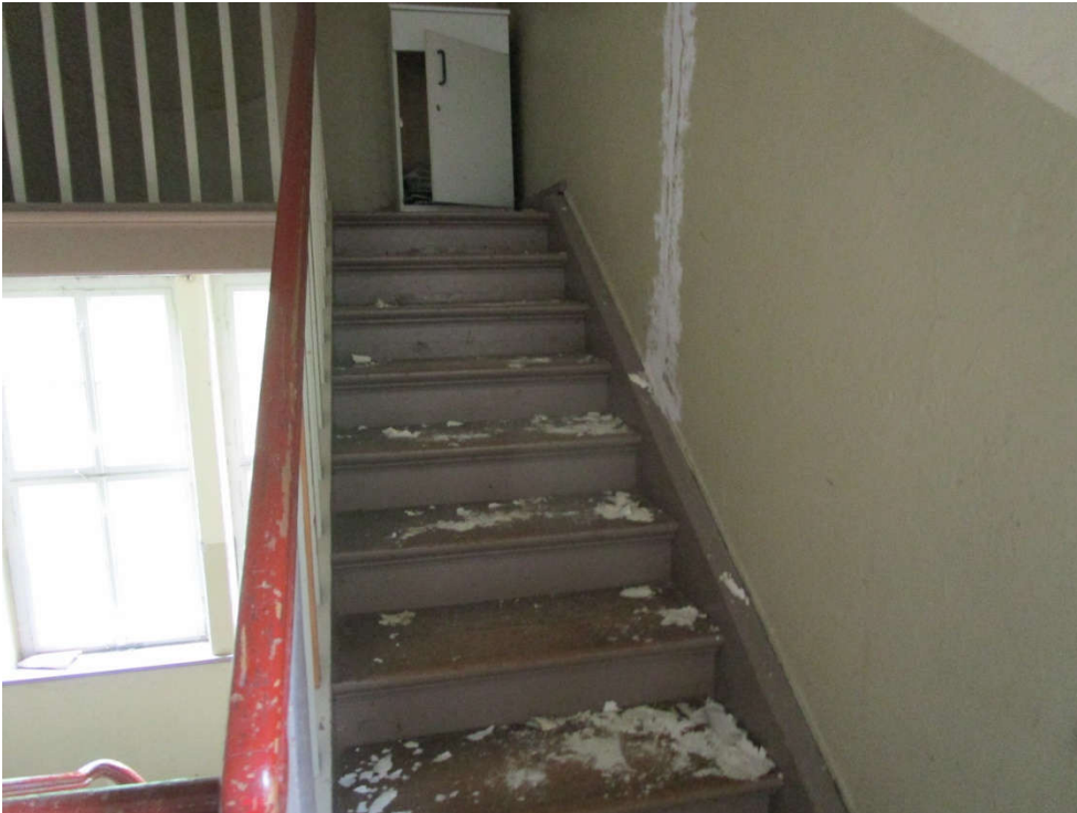
Anbau Innentreppe (Holz)
