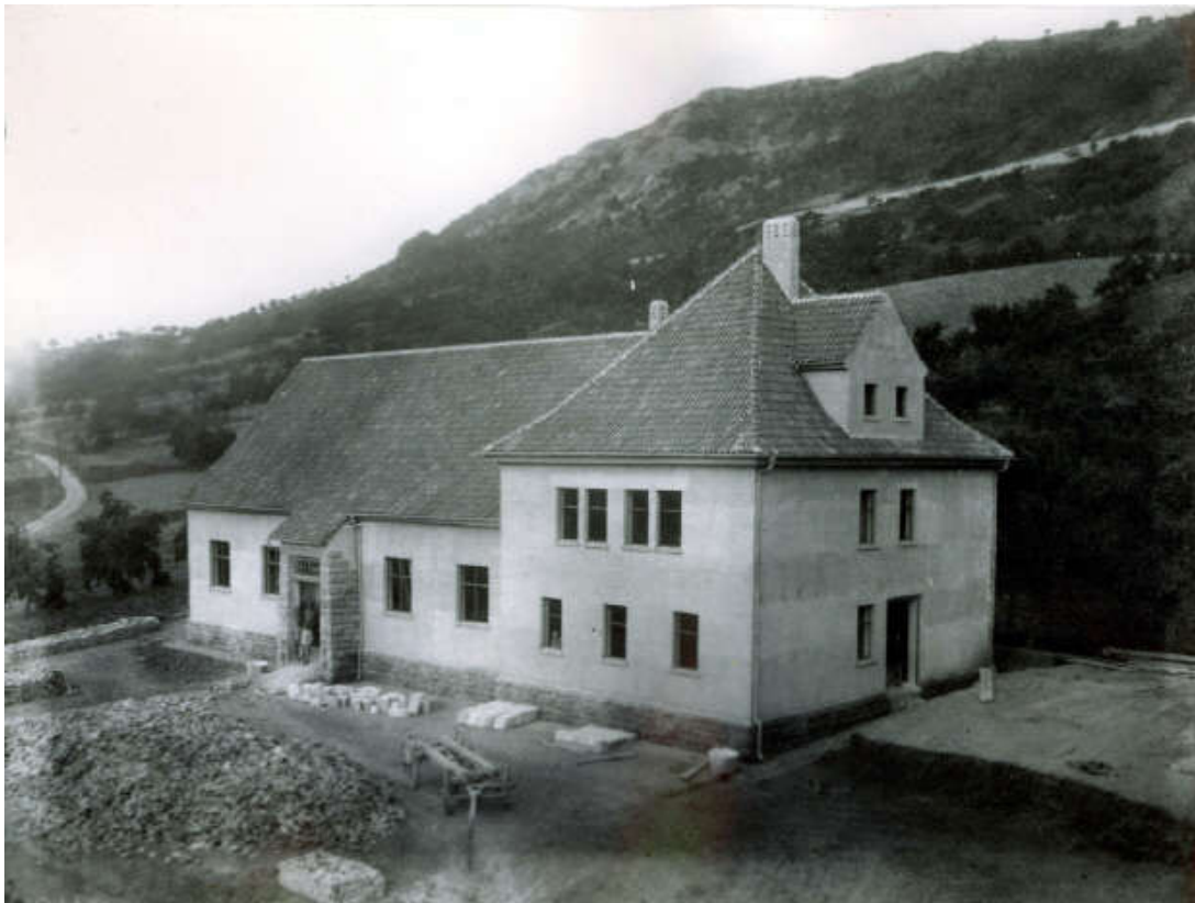
Turnhallegebäude im Zeitraum der Errichtung (ca. 1912-1914)
