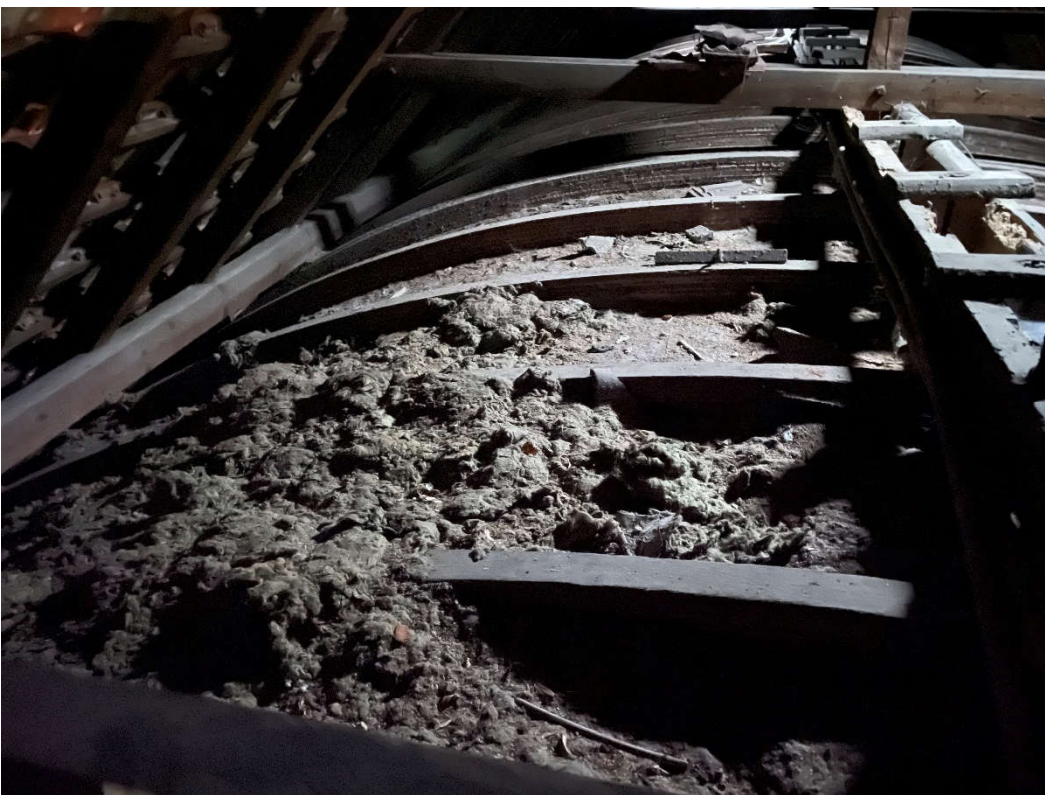
Aufsicht Tonnengewölbe im Dachraum
