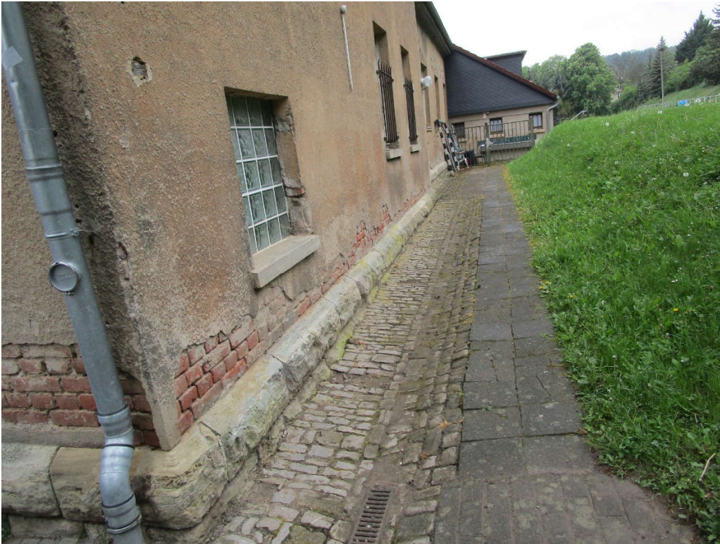
Außenfassade Putzschäden
