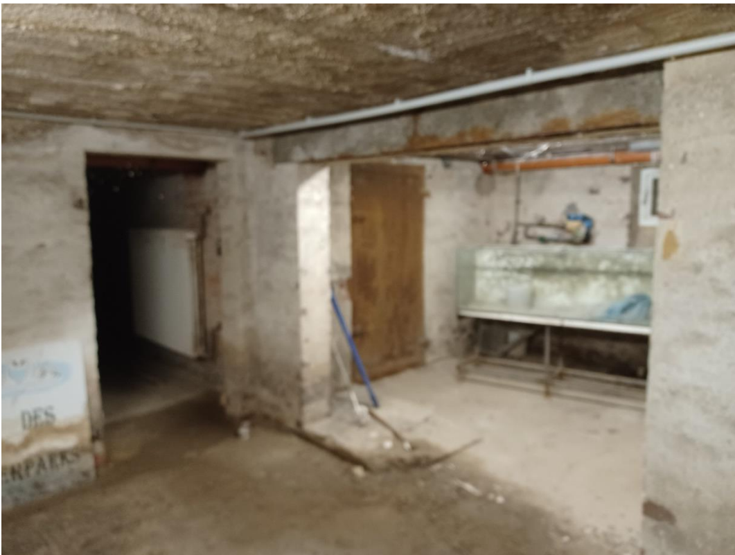
Keller (Gebäude ist teilunterkellert)
