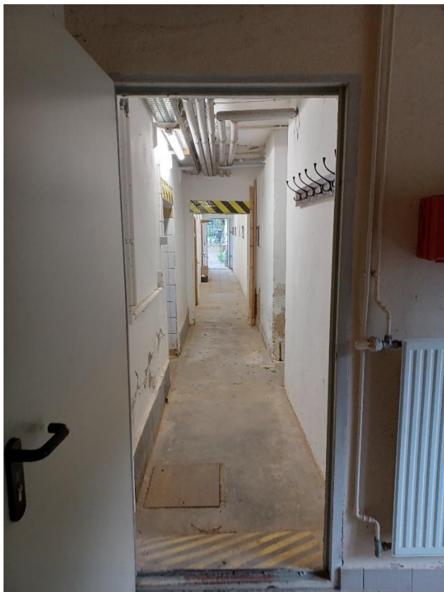
Flur mit Blickrichtung Ausgang
