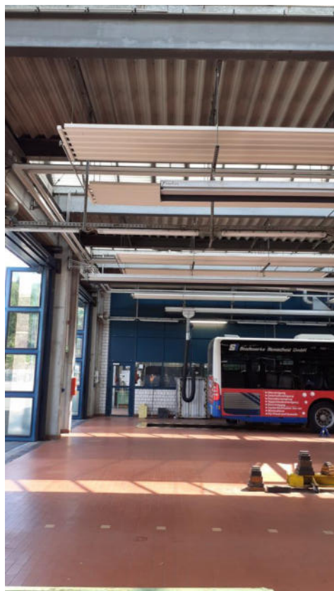
Bild 2.3: Hallenansicht (Quelle: EWR GmbH)
