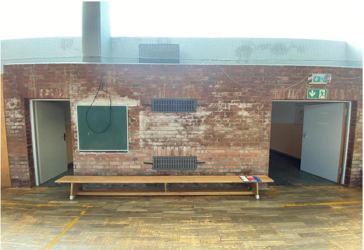
Vormauerschale der Innenwand zum Sozialtrakt, mit Lüftungsgittern zu Abluft-Ansaugung
