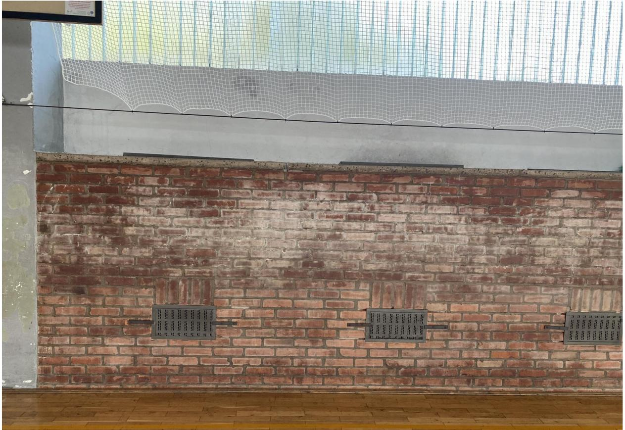
Vormauerschale der Außenwand, mit Lüftungsgittern unten und oben (Zuluft)
