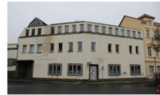
2024 - Zustand nach Umbau der Fassade
