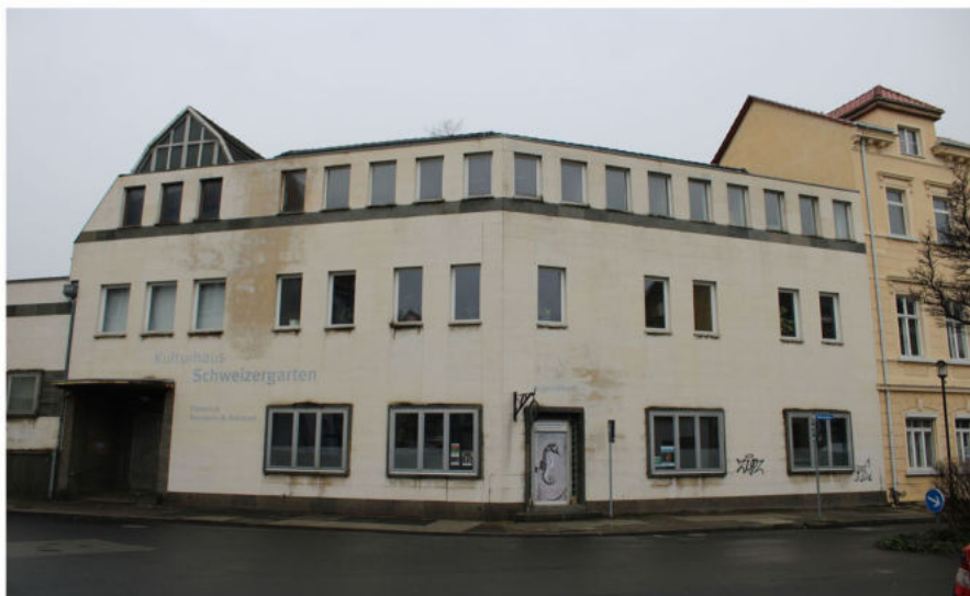
2024 - Zustand nach Umbau der Fassade
