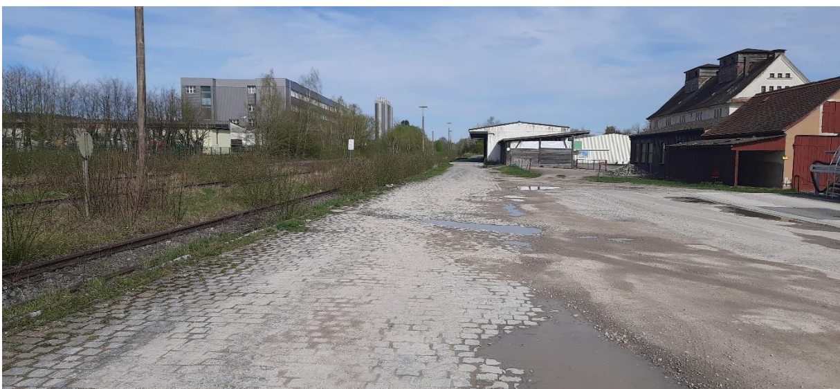
Abbildung 28: Gleistrasse im Bahnhof Feuchtwangen.
