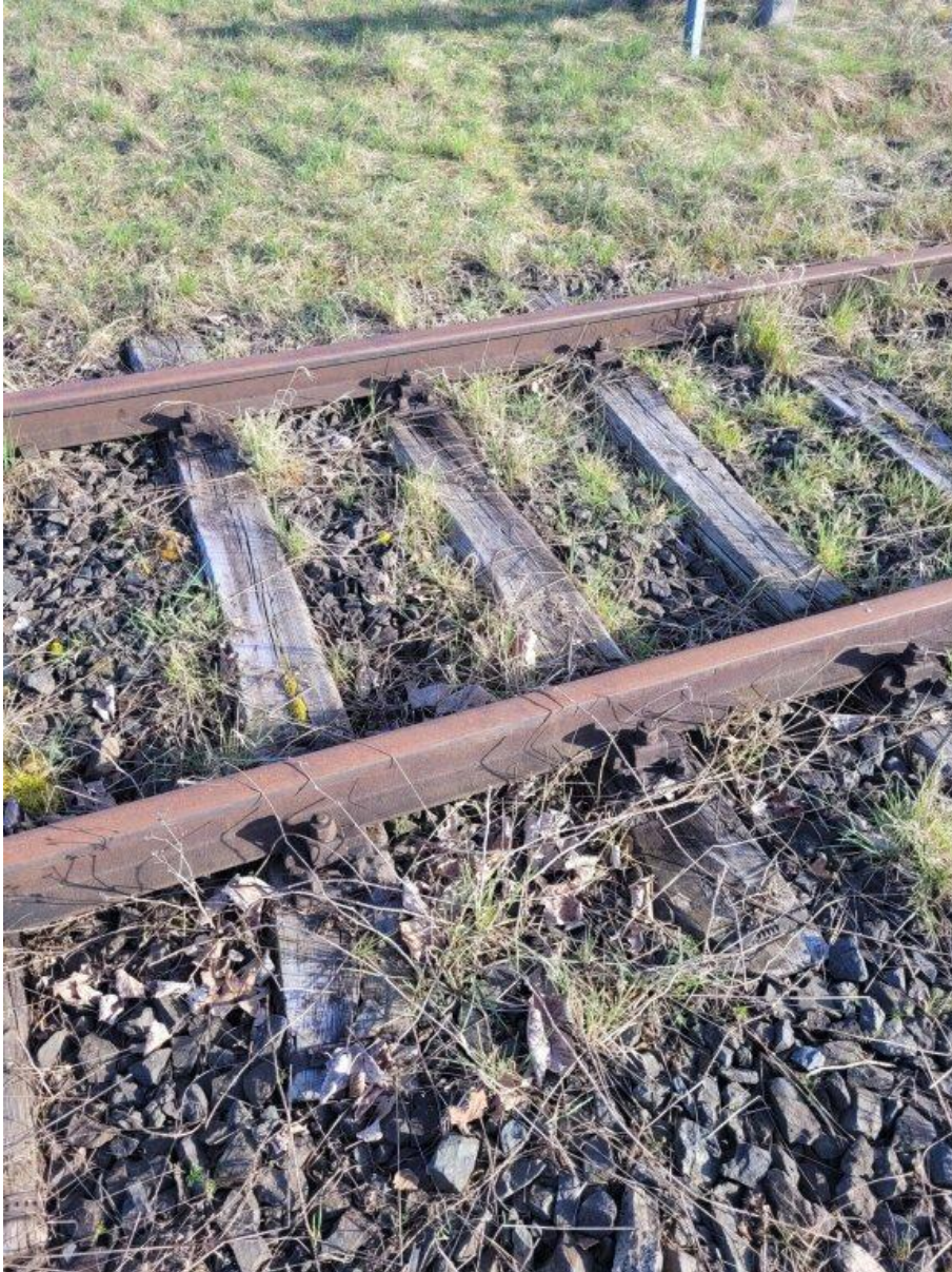
Abbildung 31: Überblick über Bereich mit Gleisen und Schotter.
