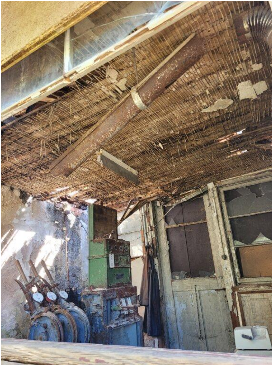
Abbildung 24: Stellwerkhäuschen in Dinkelsbühl mit Spalten und Nischen.
