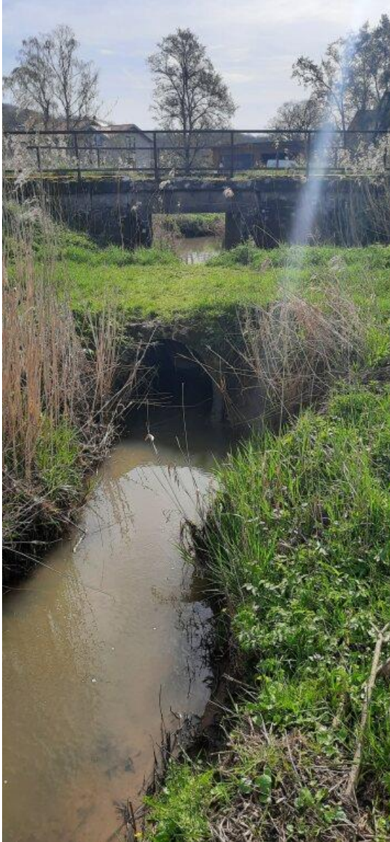
Abbildung 26: Durchlass und Gleistrasse.
