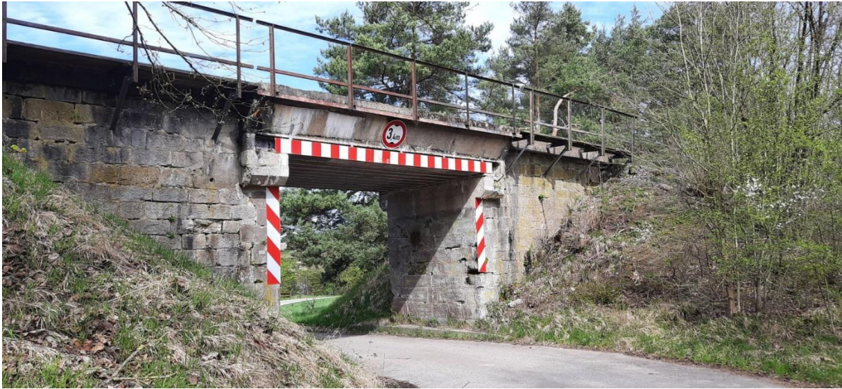
Abbildung 25: Zu erneuernde Eisenbahnüberführung bei Kaltenbronn.
