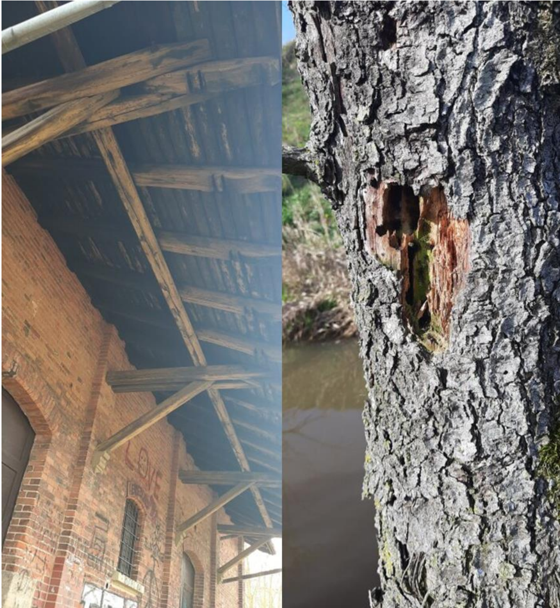
Abbildung 34: Potenzielle Fledermaushabitate innerhalb des Planungsgebietes.
