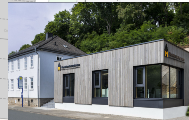
Von KMA geplantes und mit der Fa. Russ Holzbau gebautes Bürogebäude in Modulbauweise
