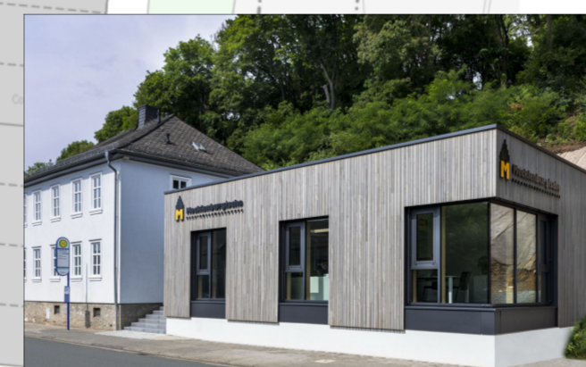
Von KMA geplantes und mit der Fa. Russ Holzbau gebautes Bürogebäude in Modulbauweise
