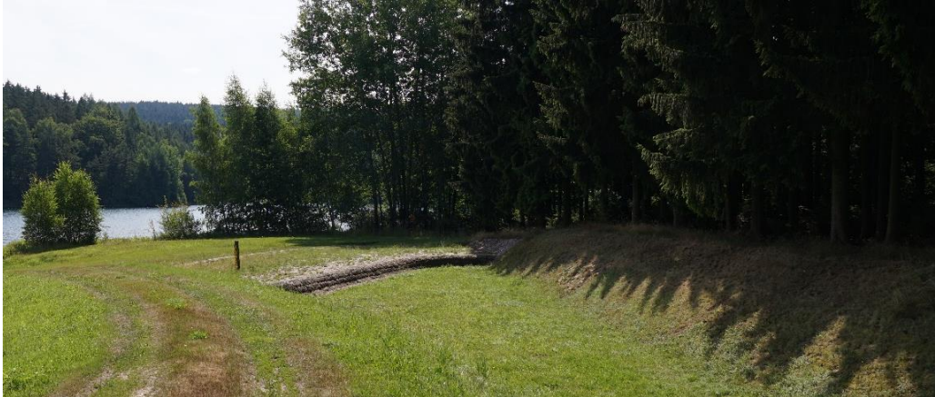
Abbildung 2: Überlaufschwelle HWE Stollberg
