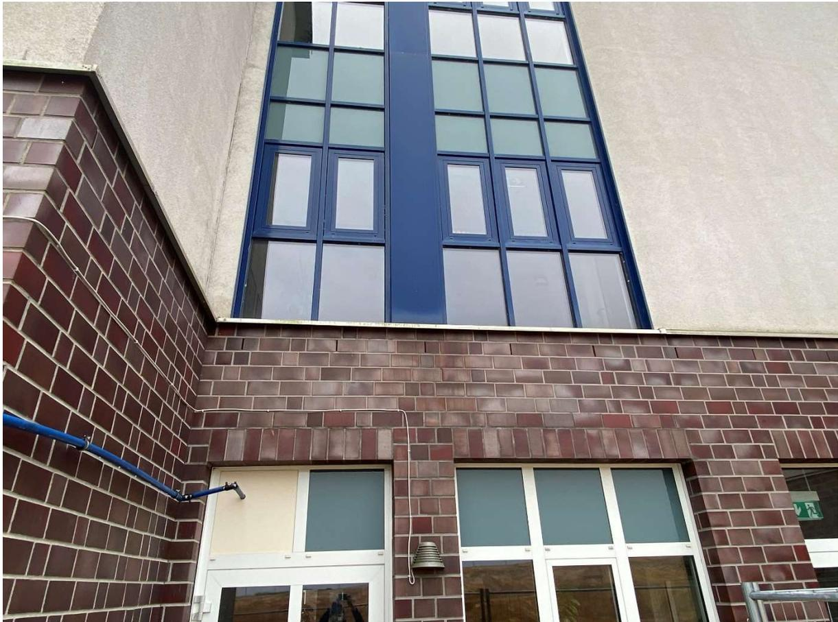
Anschluss Wand Neubau an Bestandsfassade und Fensterbank
