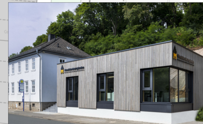
Von KMA geplantes und mit der Fa. Russ Holzbau gebautes Bürogebäude in Modulbauweise
