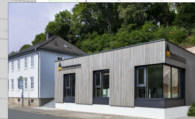
Von KMA geplantes und mit der Fa. Russ Holzbau gebautes Bürogebäude in Modulbauweise
