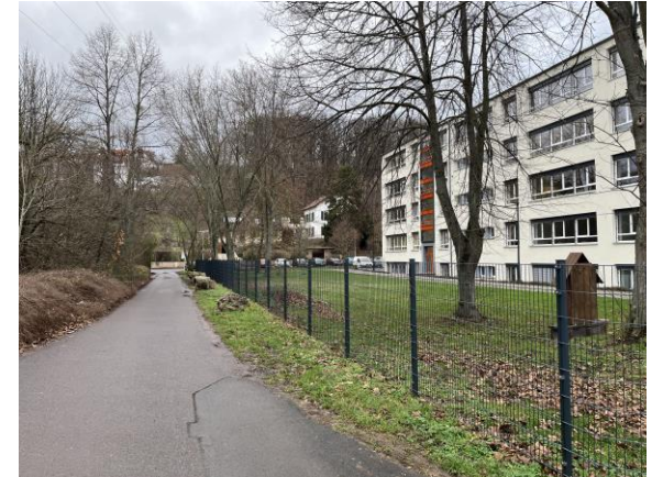
Erschließungsstraße im Westen
