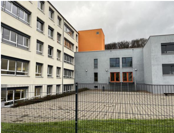
Hofeingang von Süden (Pausenbereich)
