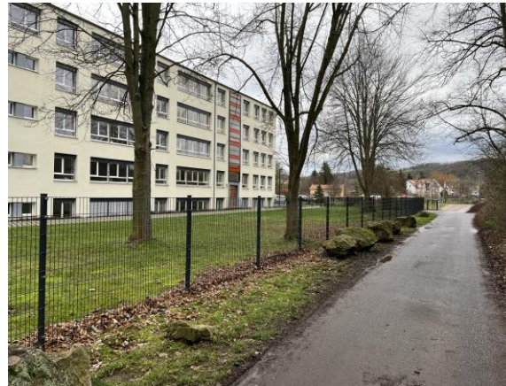
Westseite mit Erschließungsstraße
