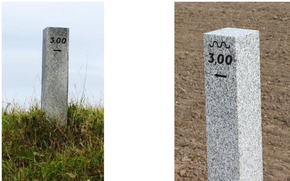
Abbildung 6 Deichkilometrierungsstein - links IST-Zustand, rechts SOLL-Zustand
